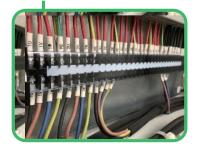
可作为周边设备的控制终端,包括污泥泵、加药泵、输送机等。
