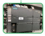
可编程逻辑控制器(PLC),可根据用户的需求提供灵活的操作和控制。
