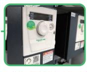
螺旋轴与搅拌桨旋转速度可由变频 器调节控制。
